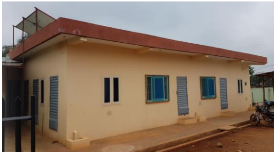
Bâtiment des dortoirs et sanitaires (2018)
